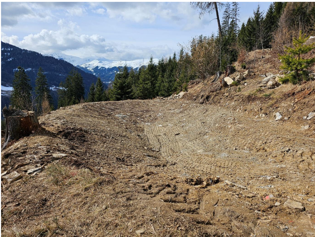
Fertig verdichtetes und Zentimeter genau ausnivelliertes modelliertes Planum. 11. März 2026
