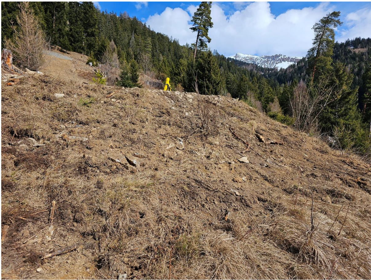
Mit Rasenziegeln und Sträuchern eingedeckter Tümpeldamm mit einem fließenden Übergang in die natürlich gewachsene Böschung. 11. März 2026
