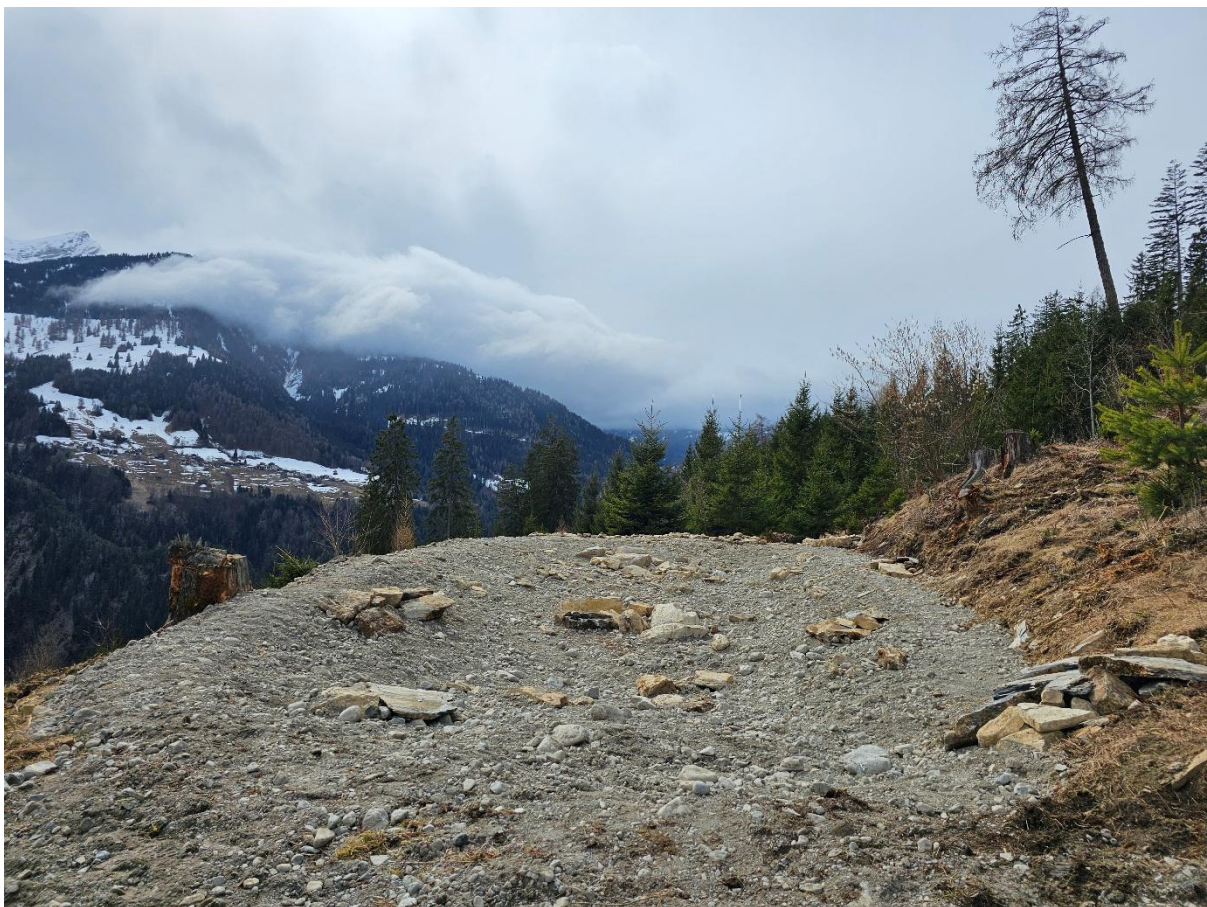
Fertiges mit lokalem Wandkies und Steinen aus dem Aushub eingedecktes Laichgewässer. 14. März 2026
