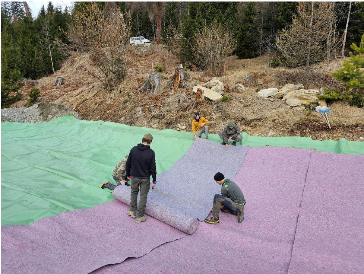
Verlegen der Abdichtung im Sandwich zwischen Schutzvlies. 14. März 2026
