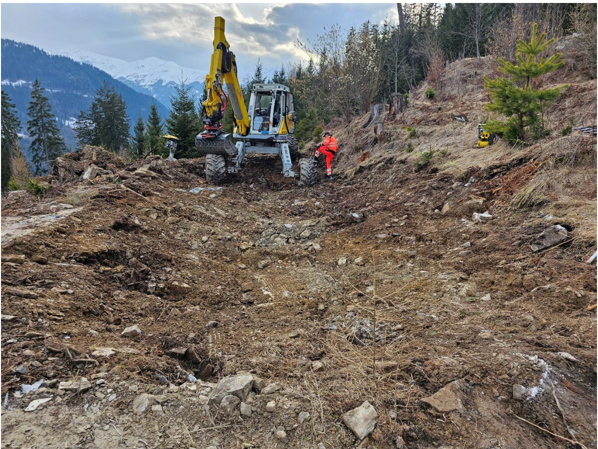
Aushub und Erdarbeiten durch Bordt-Bau AG. 9. März 2026
